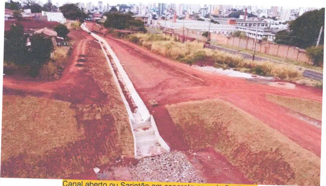
Canal aberto ou Sarjetão em concreto armado finalizado
