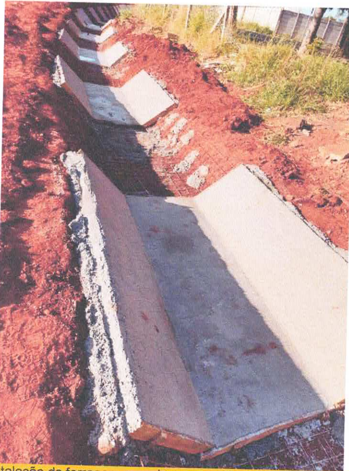
Instalação da ferragem armada e concretagem dos patamares.
