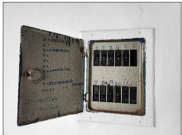
Figura 8 – Quadro de distribuição a ser substituído
