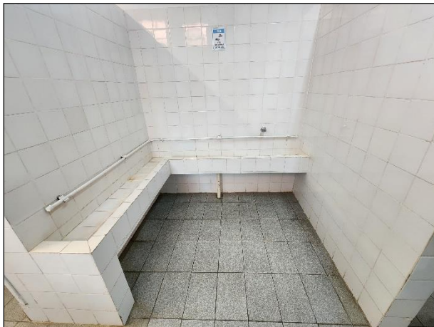
Figura 3 – Mictório será demolido e substituído por calha inox
