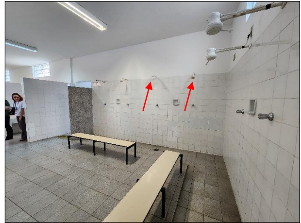
Figura 6 – Duchas ao fundo serão substituídas por chuveiros elétricos
