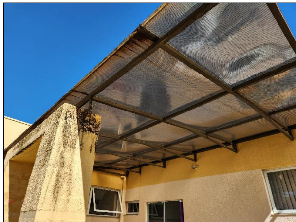
Figura 8 – Cobertura de policarbonato a ser substituída
