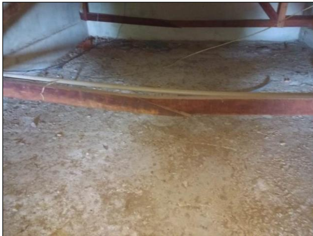
Figura 15 – estrutura de madeira deformada
