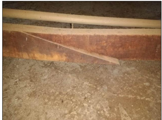
Figura 16 – estrutura de madeira deformada
