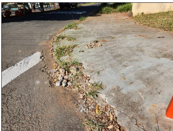
Figura 11 – guias e sarjetas a serem trocadas
